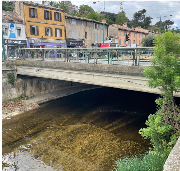
Point d'intérêt n°1 : Aménagement et inondation
