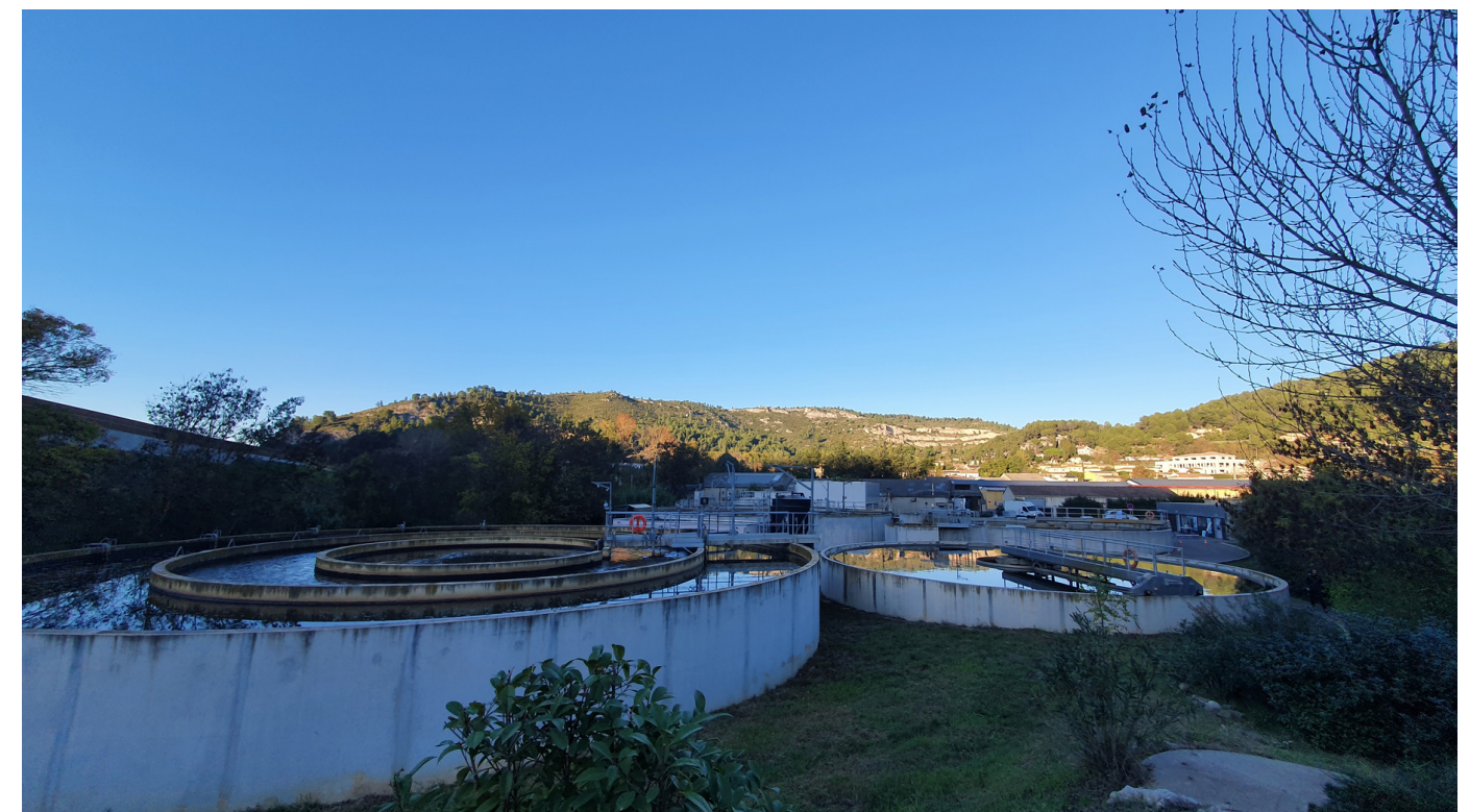
Vue d'ensemble de la STEP
