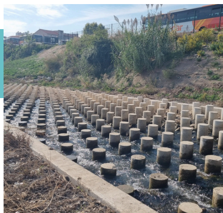
Point d'intérêt n°3 : La passe à poissons
